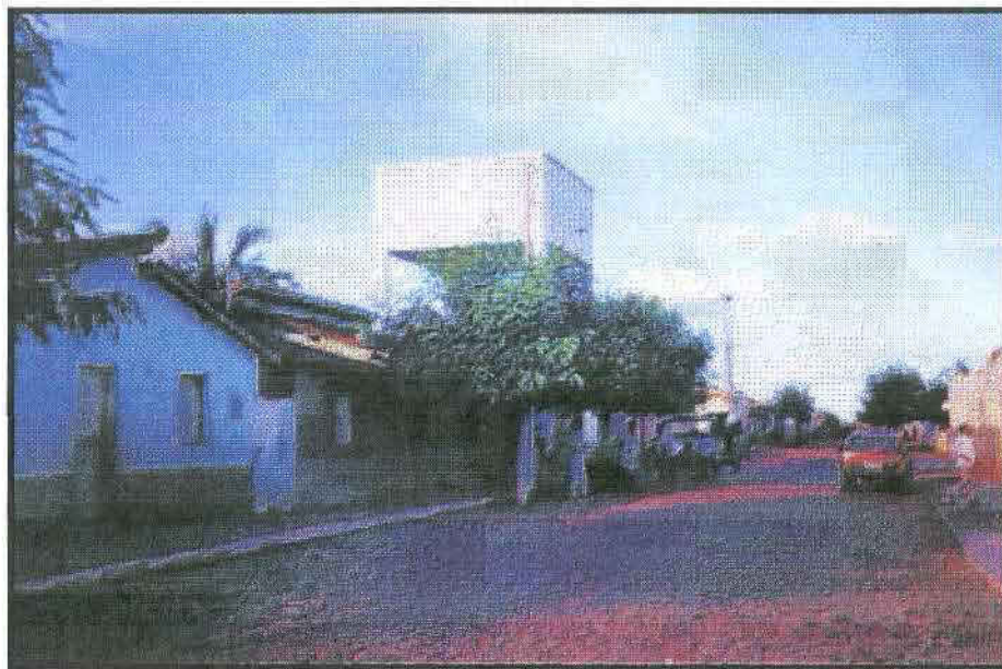
Foto 01 - Caminhamento da adutora na chegada do reservatório.
