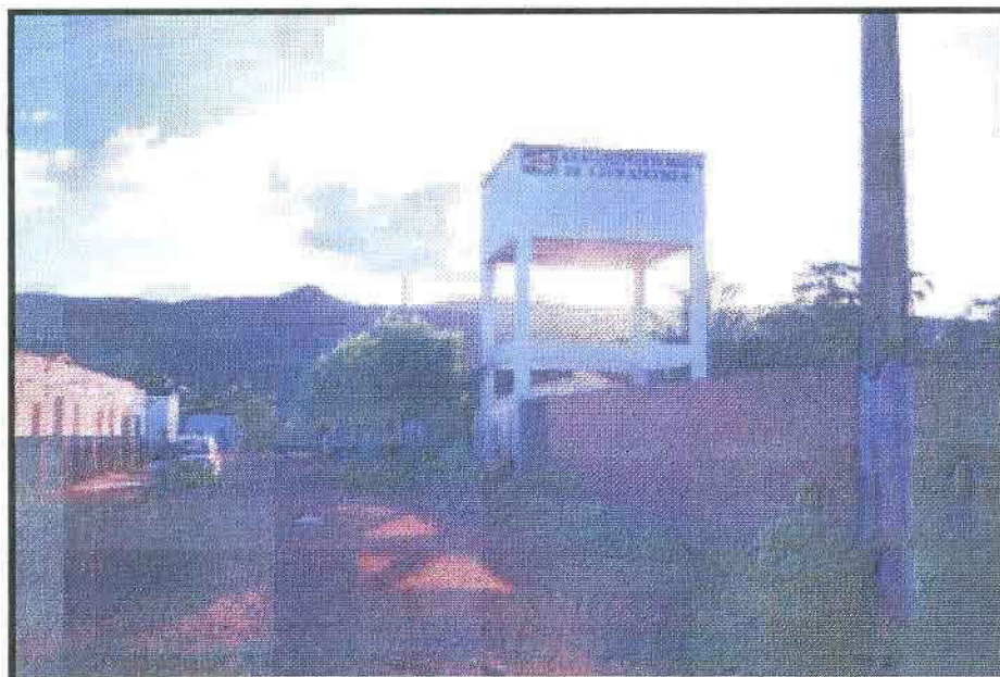
Foto 06 - Reservatório elevado construído.
